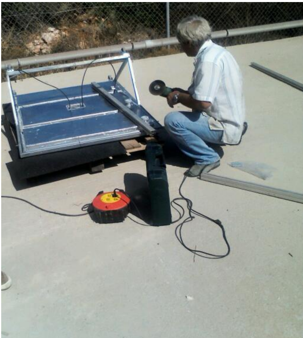
Εικόνα 2.1.5 Εργασίες τοποθέτησης δοκών στηρίξεως.
